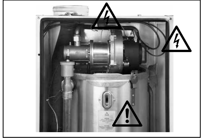
Resim: Ateşleme trafosu, yüksek gerilim ateşleme elektrodu ve ısı eşanjöründe, elektrik gerilim tehlikesi vardır. Parçalarda yanma tehlikesi vardır.
